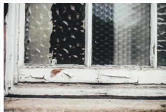
Infiltrations d'air par les ouvertures
